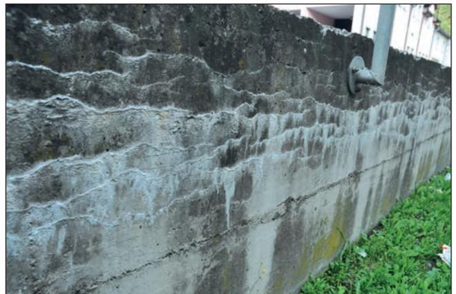
Abb. 15: Kalkausblühungen haben nichts Botanisches an sich – hier an der Betonmauer an der Hauptstraße in Helfenberg im Mühlviertel
