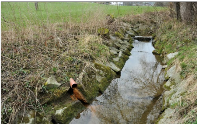
Abb. 10: Der hart verbaute Oberlauf des Altbaches in Treubach – mit Zuflüssen aus den umliegenden Wiesen.
