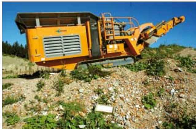
Abb. 7: Von Huflattichblättern umzingelte Brechmaschine zum Zerkleinern des Bauschutts auf der Bauschuttdeponie in Mehrnbach/Gigling.
