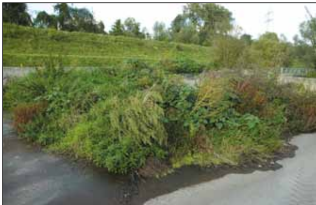
Abb. 2: Deponierung von Klärschlamm- und Kanalrückständen hinter der Kläranlage Braunau/Höft mit üppigem Pflanzenwuchs.
